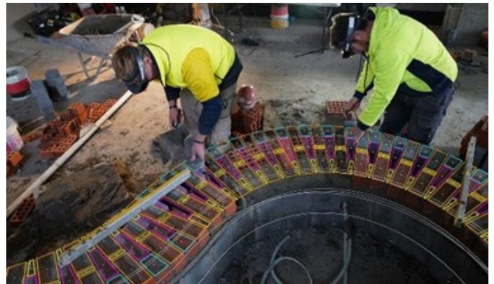
Bsp.: AR-gestütztes Bauen mit Microsoft Hololens®
